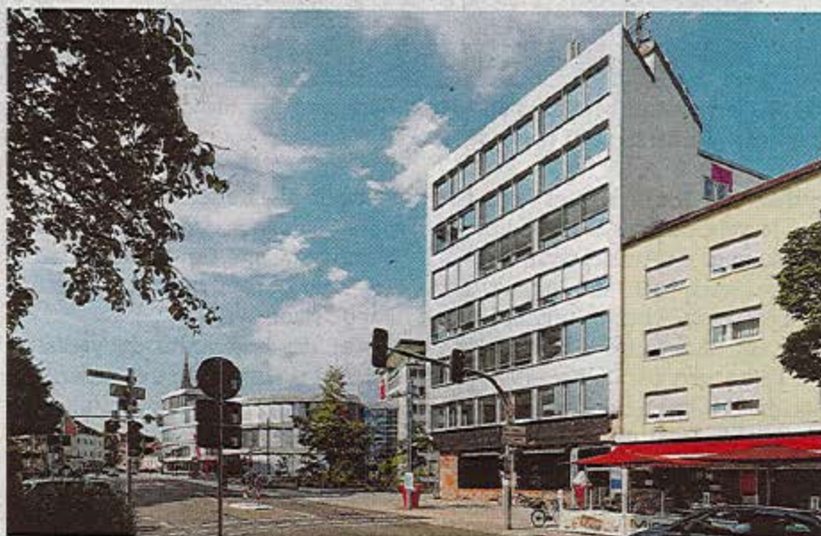
Das Geschäftsgebäude an der Marienstraße sieht fast fertig aus – bis auf das Erdgeschoss. Dort baut die VR-Bank Neu-Ulm noch bis 2019 um. Foto: Alexander Kaya
